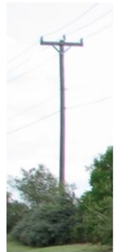
Una línea de distribución típica
